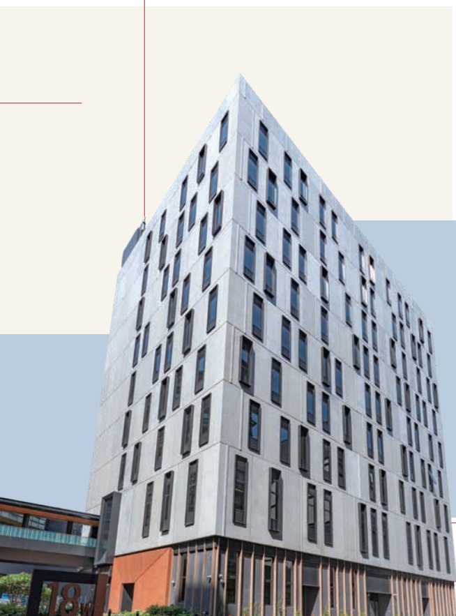
香港科學園第二期擴建工程 (SPX2) 18W (前稱12W-A) 大樓
